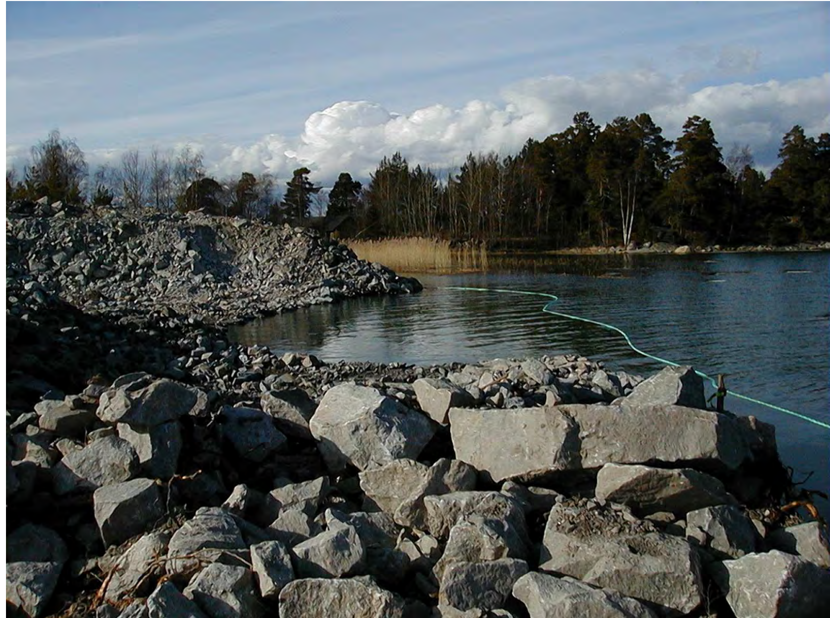
Massorna vid Älvsnabben som härstammar från sprängning av tunneln till Muskö och av varvet. Dessa massor har transporterats med pråm till Nynäshamn för ett bygge av en ny pir i Nynäshamns hamn
