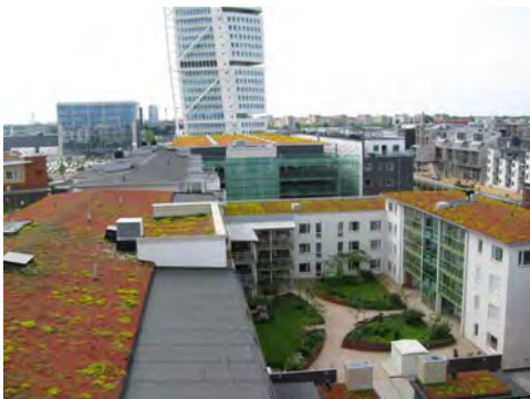
Sedumtak. Exempel Västra Hamnen, Malmö
