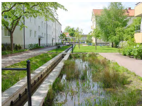
Grönt / vattenfyllt dike. Exempel Augustenlund, Malmö
