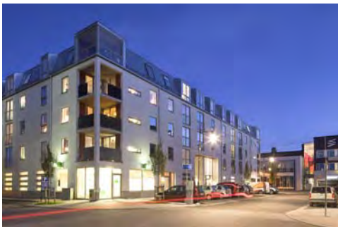
Hörnbalkonger mot gata. Exempel Söderstaden, Kungsbacka
