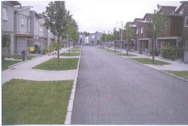
Figur 8:3 Exempel på infiltrationsstråk med träd mellan gata och hus från Biskopshagen Växsjö, ur P105 figur 9.37.
