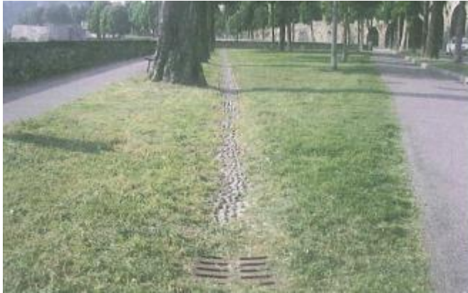
Figur 8:2 Exempel på öppna dagvattenrännor ur P105 figur 9.39.
