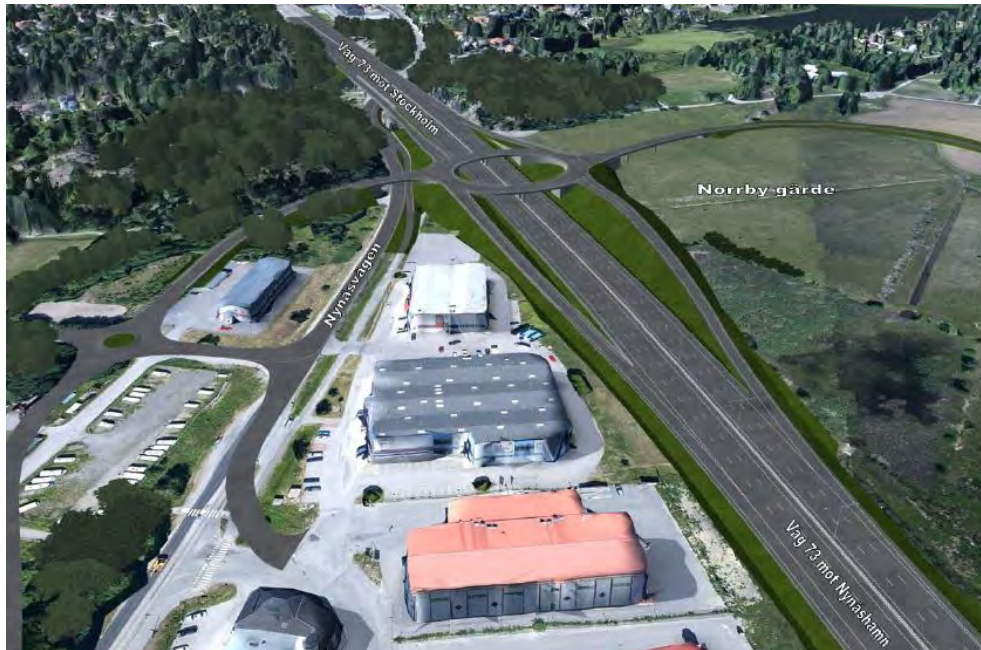
Figur 1-8 Förslag till utformning av trafikplats Vega, vy från sydväst med Kvarntorps industriområde i förgrunden. Stadsdelen Vega kommer att tillkomma väster om industriområdet. Källa: Trafikverket (2011), Väg 73 Trafikplats Vega MKB Sammanfattning
