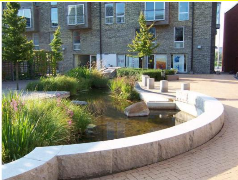
Figur 7:3. Öppen fördröjningsdamm i boendemiljö
