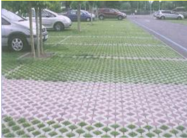
Figur 7:6. Parkeringsyta anlagd med betonghålstén (Svenskt vatten P105, figur 9:19).
