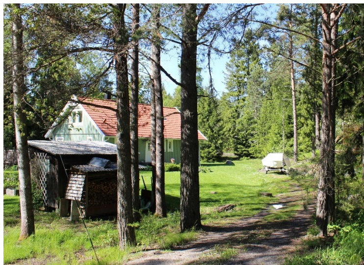
Exempel på befintlig bebyggelse i Hermanstorp
