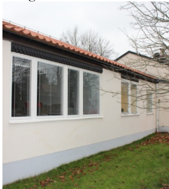
Skolbyggnaden(2) är uppförd i lätt och väl proportionerad putsarkitektur med en rad tidstypiska originaldetaljer bevarade. Exempelvis partier med kyrkspån ovan fönsteröppningarna.
