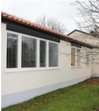
Skolbyggnaden 2 är uppförd i lätt och väl proportionerad putsarkitektur med en rad tidstypiska originaldetaljer bevarade. Exempelvis partier med kyrkspån ovan fönsteröppningarna.
