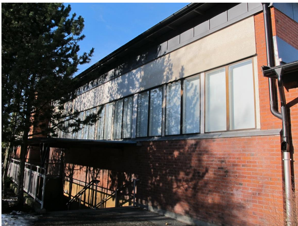
LP_2015_00048 Fönstren utanför aulan har minskats i höjd.
