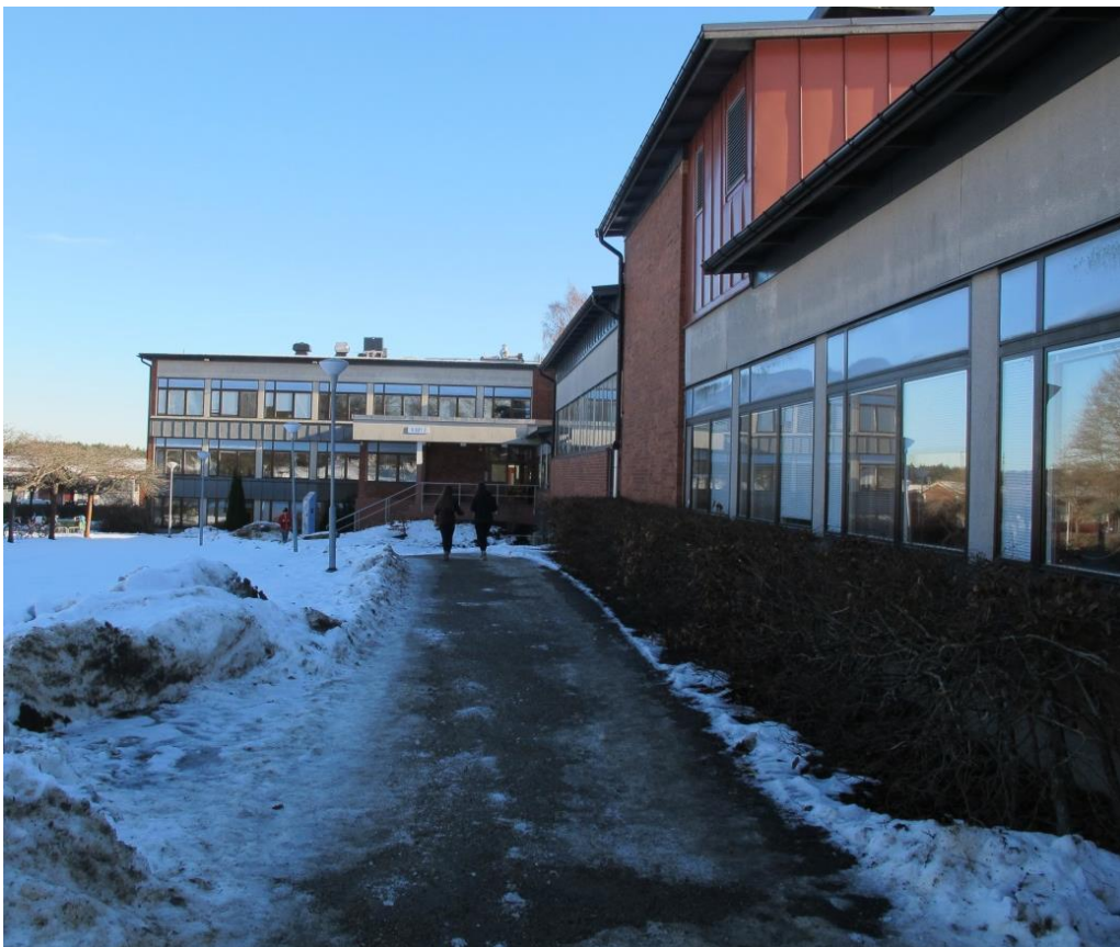
LP_2015_00043 Ribby II sedd från väster med norrfasaden i bild och huvudingången i bakgrunden.
