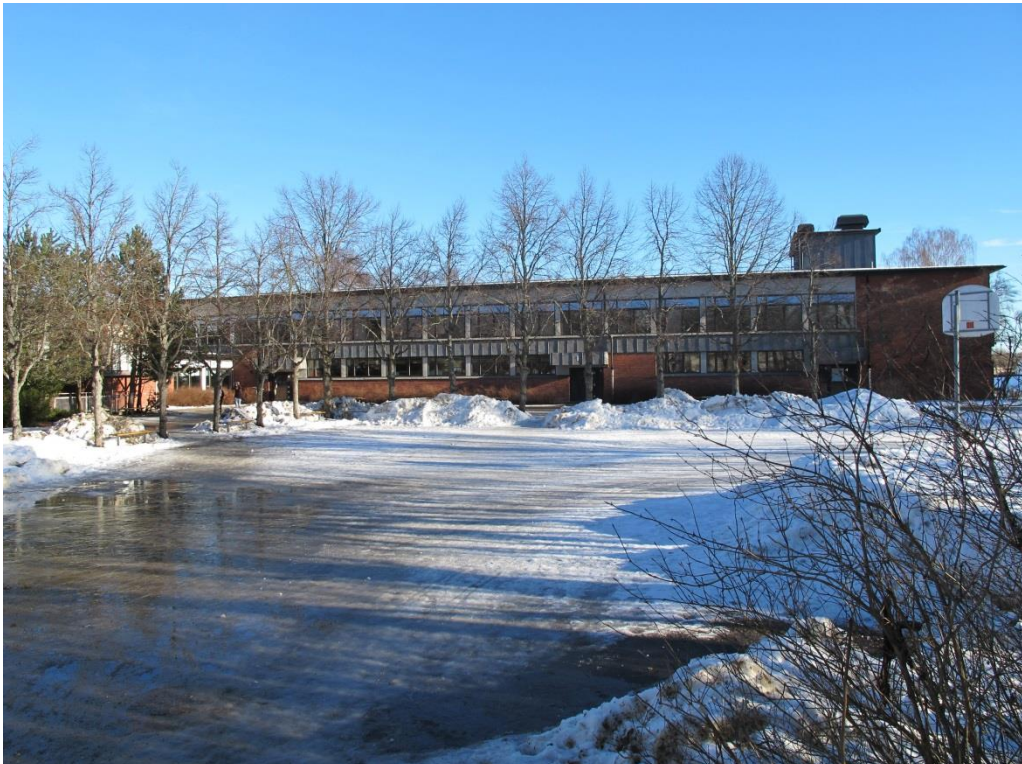
LP_2015_00050 Skolgården med en västfasad på gården i bild. Träden är placerade i en L-form på skolgården.
