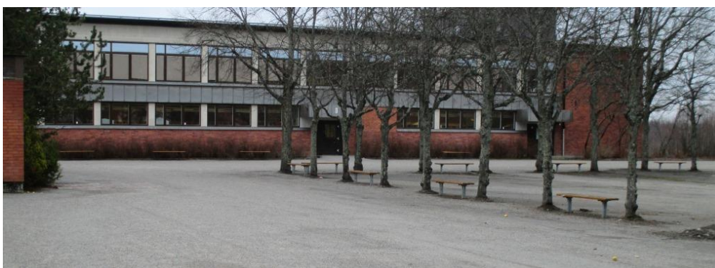
Figur 7:5 Skolgården vid 60-talsskolan sedd från väster mot öster. Foto: Sofia Åkerman 2014-03-05.
