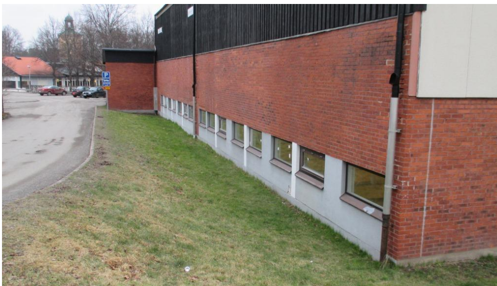
Figur 3:4 Takdagvattnet på idrottshallens västra sida vilket leds ned i marken till troliga ledningar. Foto: Sofia Åkerman 2014-03-05.
