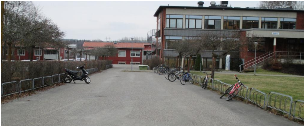
Figur 7:6 Cykelparkeringen och 60-talsskolan sett från väster mot öster och Ribby ängar. Till vänster syns bilparkeringen. Foto: Sofia Åkerman 2014-03-05.
