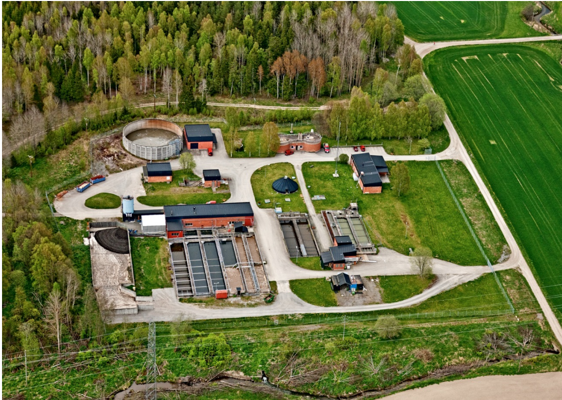
Figur 5 visar en flygbild över det nuvarande avloppsreningsverket med Marielundsvägen till höger i bild och Hågaån i nederkant. Bilden är tagen från väst.
