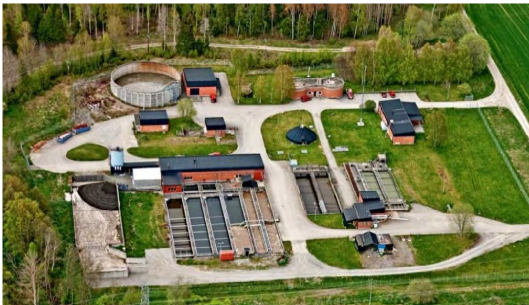
Figur 10. Befintlig anläggning för avloppsreningsverket på fastigheten Fors 7:1.
