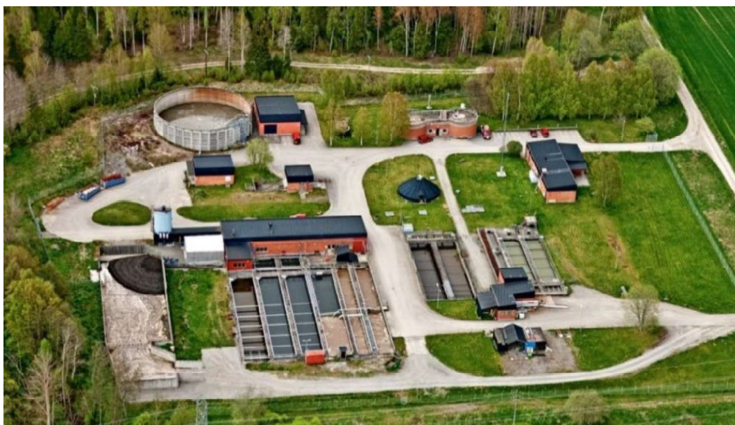
Figur 10. Befintlig anläggning för avloppsreningsverket på fastigheten Fors 7:1.
