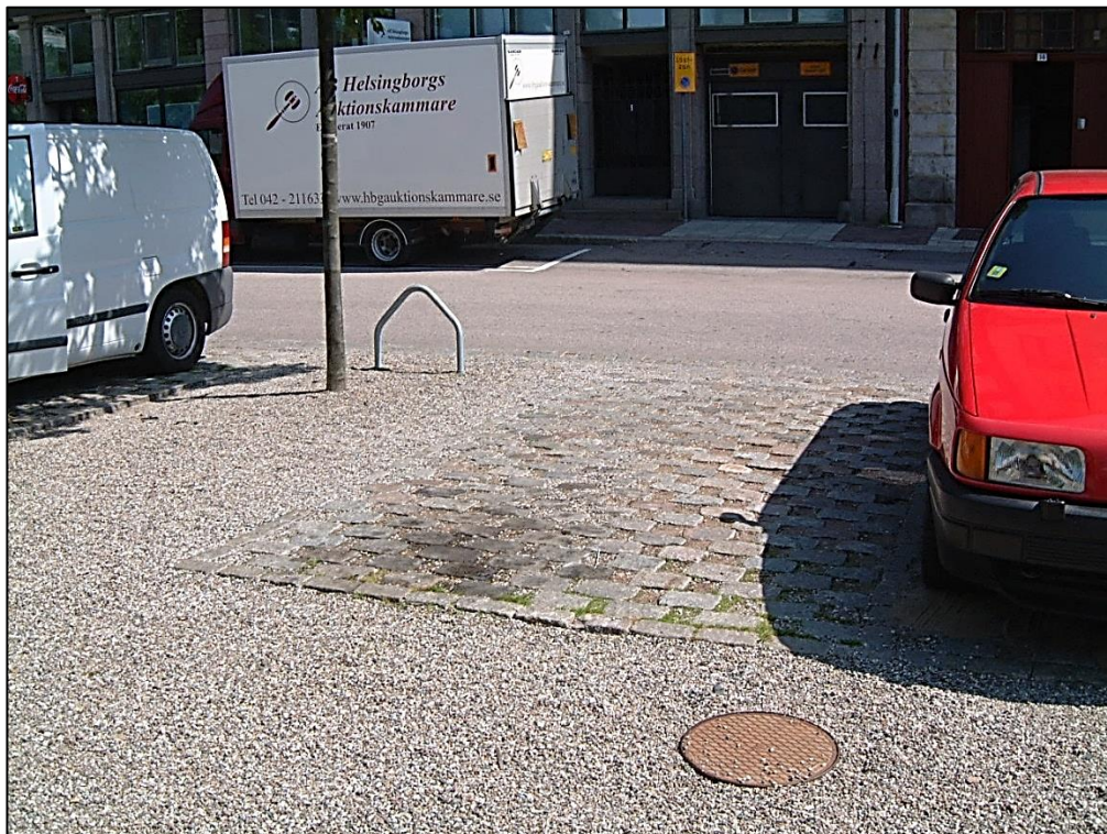
Figur 26. Exempel på genomsläpplig yta (plattbeläggning) (Foto: Norconsult)
