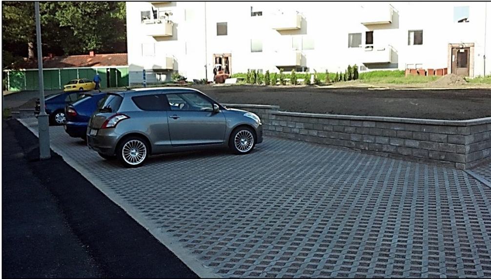
Figur 25. Exempel på genomsläpplig yta (gräsarmering) (Foto: Norconsult)
