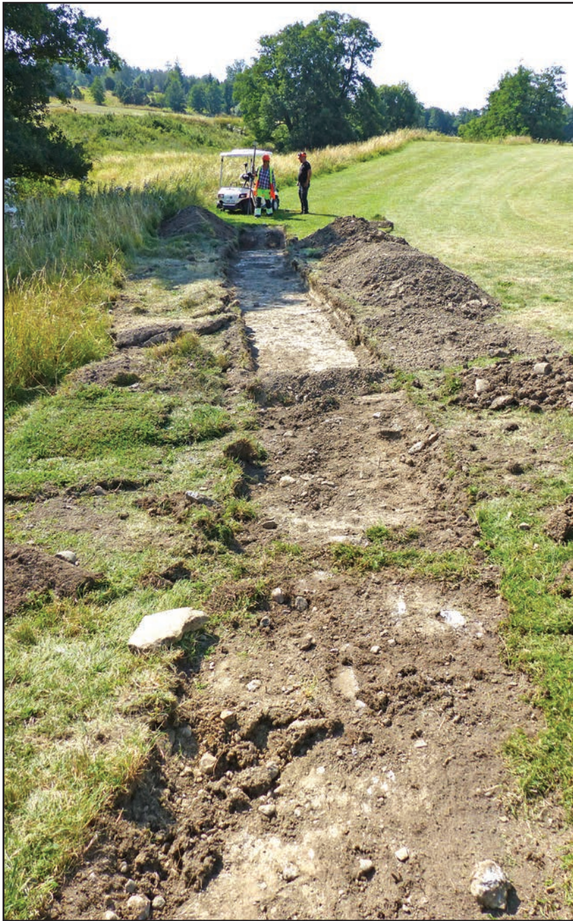
Fig. 13. Objekt 20, plats för en bro över Vitsån. I schaktet, hitåt i bilden, noterades en äldre vägbana i form av hårdpackat grus. Vid metalldetektering framkom två hästbroddar. I övrigt noterades rester av betongfundament, i slänten ner mot ån samt några större stenblock i kanten av ån. De senare kan vara rester av någon äldre konstruktion.. Det bedöms inte finnas något av antikvariskt intresse i området. Vy från öster.
