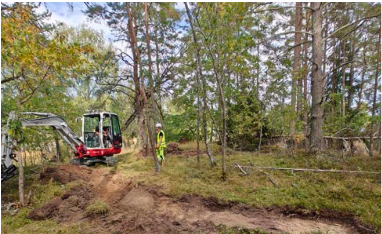
Fig. 4. Schaktning invid gravfältet L2014:4649. Foto från sydväst.
