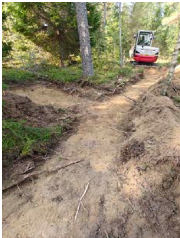
Fig. 7. Schakt vid boplatssområde L2020:8555. Foto från NÖ
