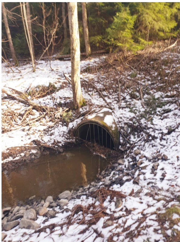
Figur 35. Bild på Åbyån och trumman som leder vattnet under Nynäsvägen och Nynäsbanan
