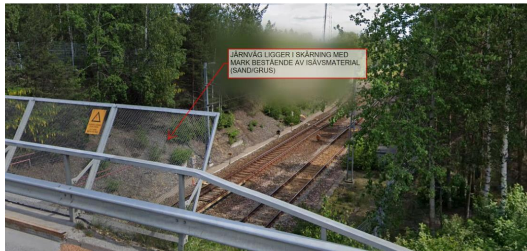
Figur 3. Förhållandena (bild från Google gatuvy, se pil i figur 2) i skärningssslätt överensstämmer med SGU:s jordartskarta. Järnvägen och området väster däremot vilar på mäktiga lager av isälvssediment.
