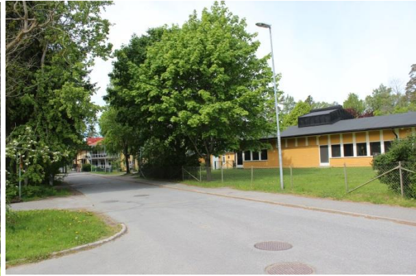
Befintliga lövträd mot gatan. (Vy från Bokstigen.)
