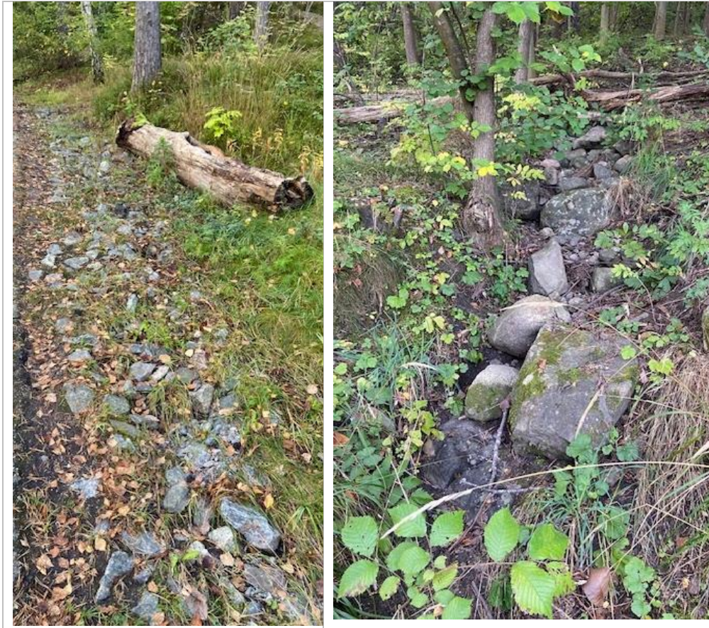
Figur 24. Exempel på erosionsskydd i brant naturslänt. Till vänster ses ett erosionsskydd av sprängsten och till höger en variant med natursten.
