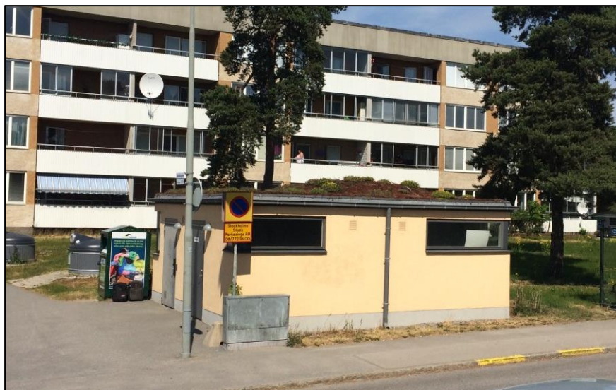
Figur 7-3. Exempel på ett grönt tak (sedum) på ett sopsorteringshus i Östberga, Stockholm (Geosigma).
