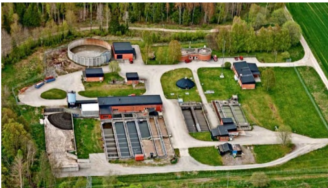
Figur 10. Befintlig anläggning för avloppsreningsverket på fastigheten Fors 7:1.
