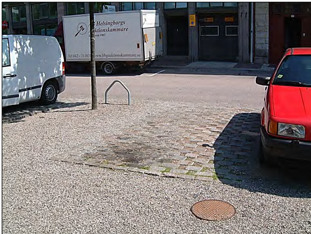
Figur 26. Exempel på genomsläpplig yta (plattbeläggning) (Foto: Norconsult)
