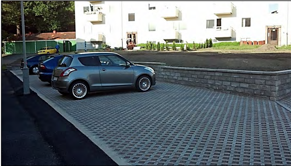
Figur 25. Exempel på genomsläpplig yta (gräsarmering) (Foto: Norconsult)
