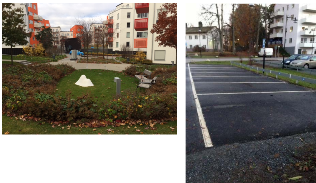
Figur 12. I bilden till vänster en nedsänkt grönyta som avvattnar omkringliggande gångvägar. Grönytan har anordnats med bräddmöjlighet till dagvattenledningsnätet. I högra bilden visas en hårdgjord parkeringsyta som avvattnas till en grönyta/infiltrationsstråk.
