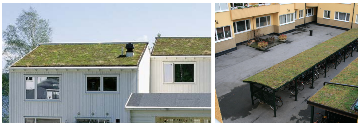
Figur 10. Gröna tak på huvudbyggnad och komplementbyggnad.
