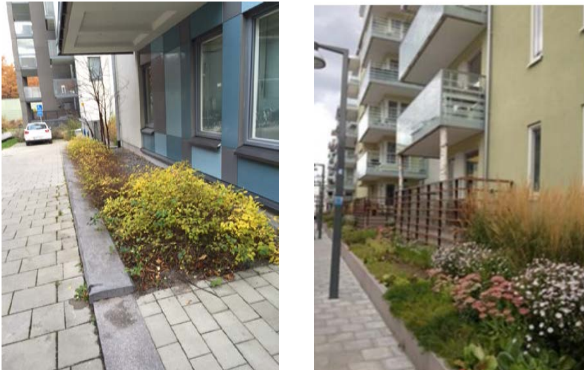
Figur 8. Växtbädd intill hus, för fördröjning och avledning av dagvatten från tak.
