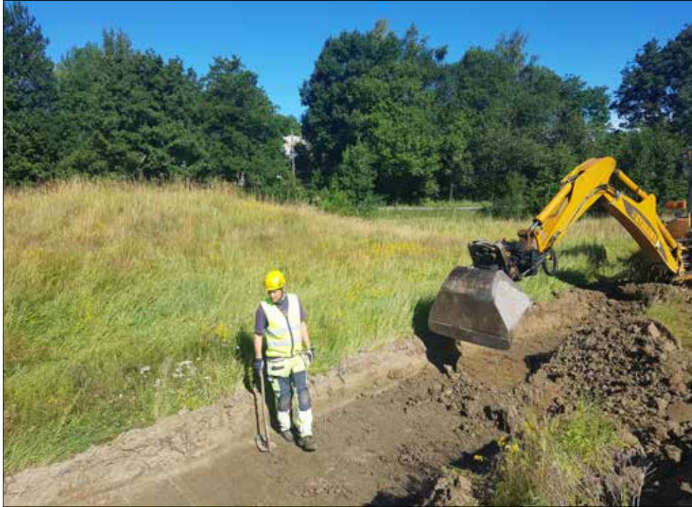
Figur 18. Schakt 48. I bakgrunden syns högen L2014:3032. Foto från sydöst av Reidar Magnusson.
