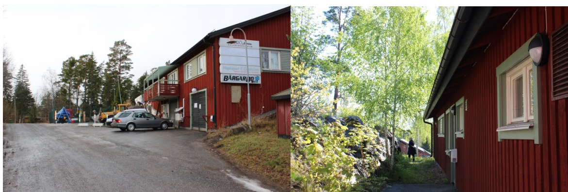
Fastigheten Vadet 3:240 ligger orienterad så att den har kontakt med både gatan och naturområde.
