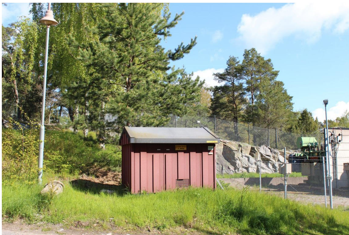
Transformatorstation som delvis står på fastigheten Vadet 3:240.
