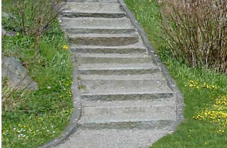
Trappväg, steg av granit och lutande yta av grus.
