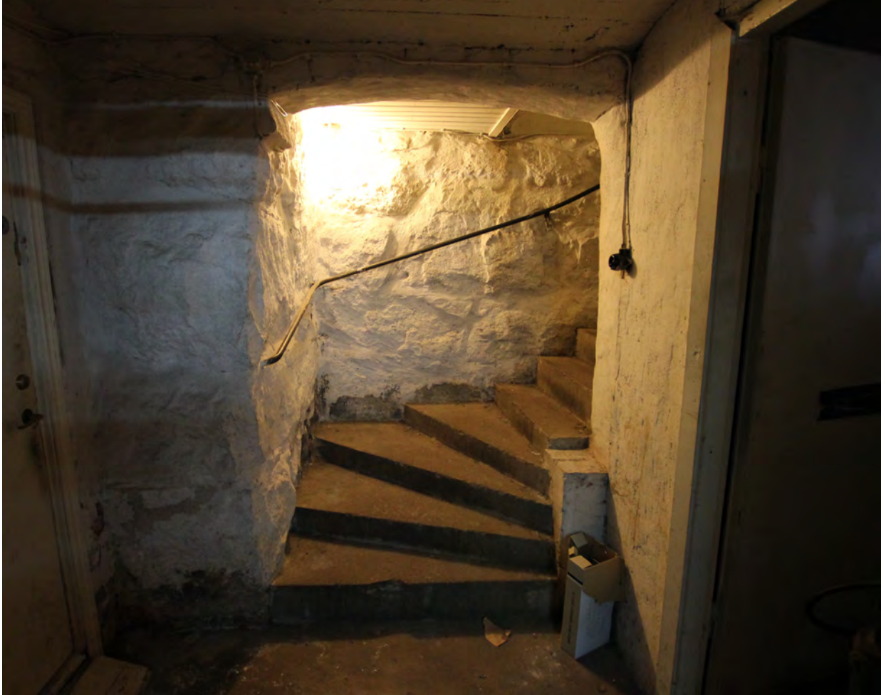
KÄLLAREN MED MURADE VÄGGAR, BETONGTRAPPA, UNDERTAK I PÄRLSPONT OVAN TRAPPAN OCH SIRLIGT TRAPPRÄCKE
