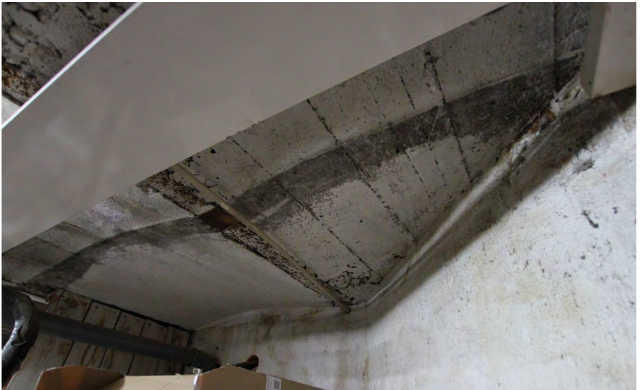
KÄLLARENS STICKVALV I BETONG MELLAN JÄRNBALKAR
