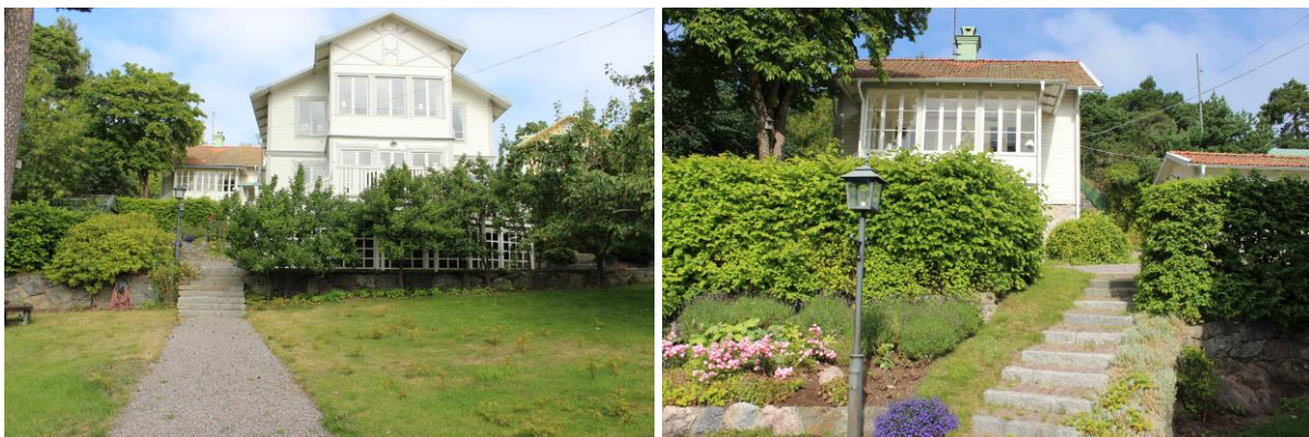
Den vänstra bilden visar den södra huvudbyggnaden med den nordligare i bakgrunden och den högra bilden visar den nordligare byggnaden med komplementbyggnad.
