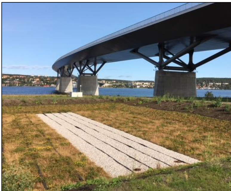
Figur 15. Exempel på nedsänkt växtbädd (Larm & Blecken, 2019).
