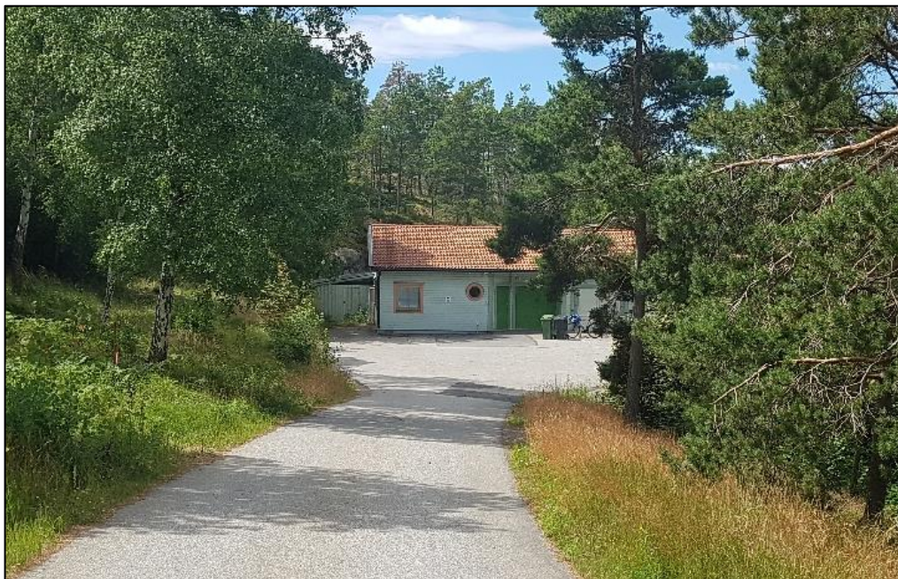
Figur 4. Dalarö avloppsreningsverk (foto: Norconsult).
