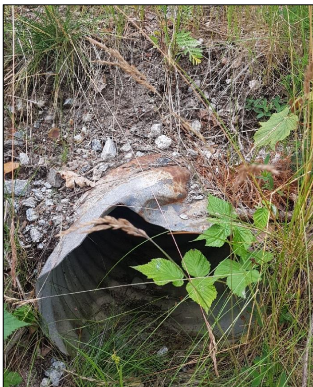
Figur 10. Dagvattenledning under väg som leder ned till reningsverk (foto: Norconsult).
