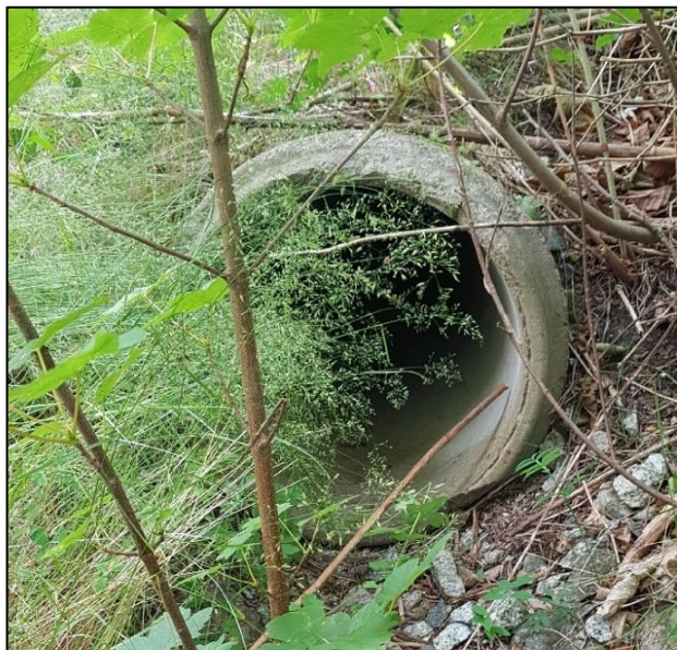
Figur 9. Inloppet till dagvattenledning under Smådalarövägen (foto: Norconsult).
