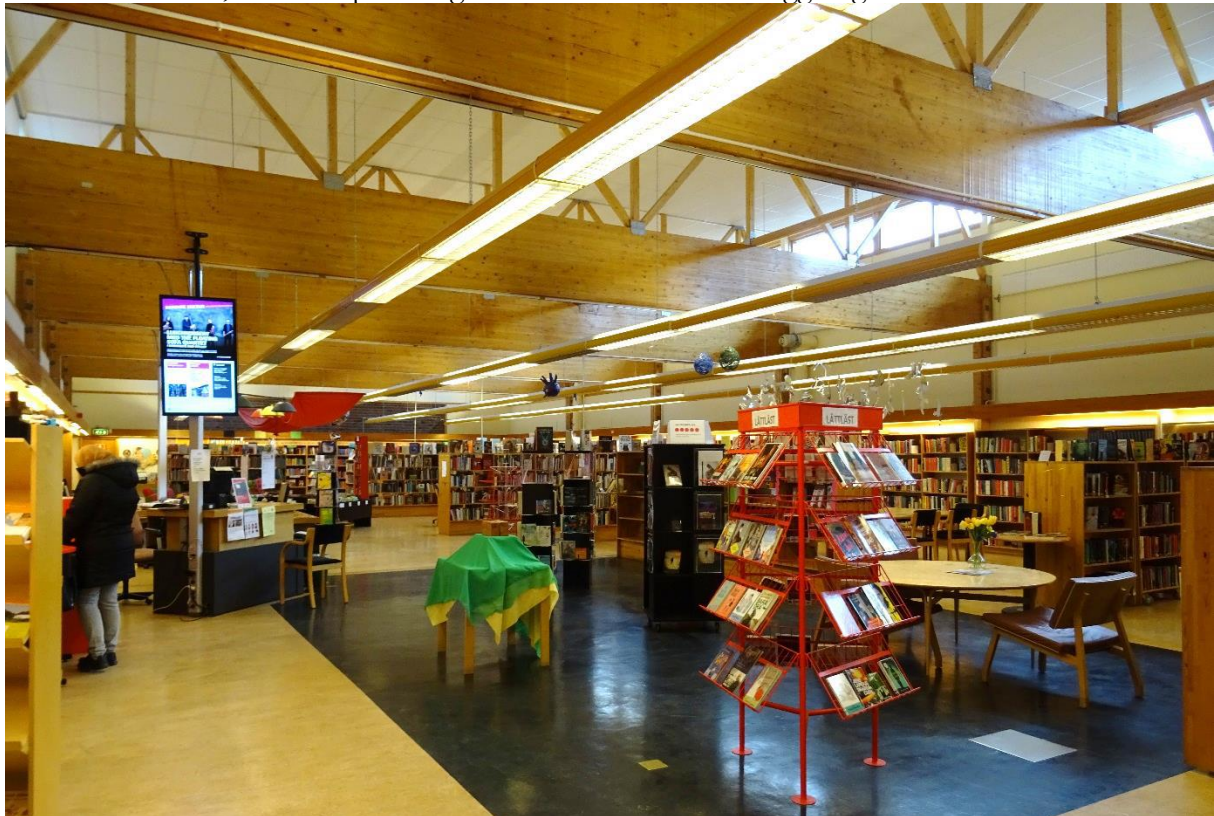
Figur 8. Bibliotekets interiör i Jordbromalmsskolan. De grova limträbalkarna av furu är synliga (Norconsult, 2019).
