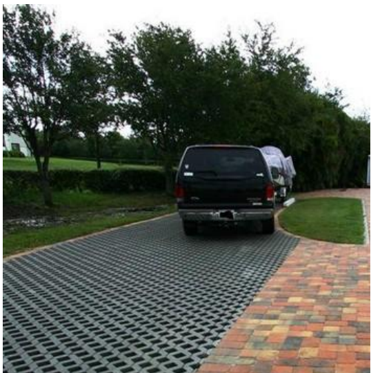
Figur 14. Exempel på LOD-tekniker, gröna öar på parkeringsplats, gröna tak samt genomsläpplig beläggning (hålstensyta av betong).
