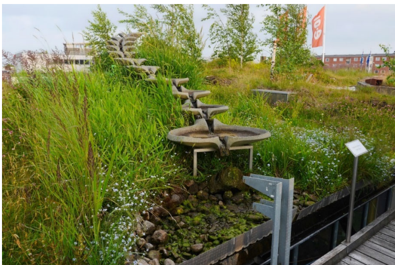
Figur 18 En exempelbild på ett semi-intensivt grönt tak (Klimatanpassningsportalen, 2017).
