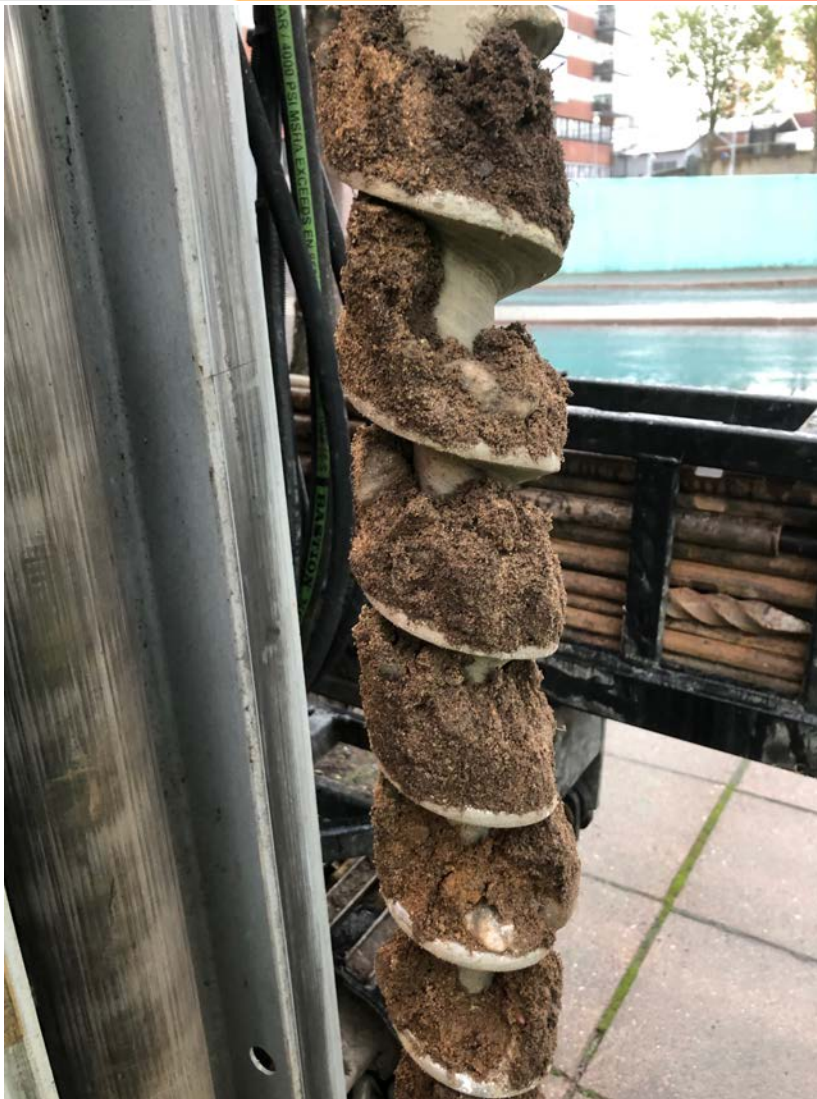
Figur 4. Samtliga prover togs direkt från skruven. Det yttre materialet skrapades bort för att minimera risken för kontaminering av ovanliggande jordlager då skruven dras upp ur marken. Foto Geoveta.
