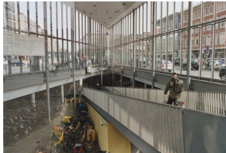
Cykelgarage vid Radstation Münster, Tyskland Fotograf Krister Isaksson
