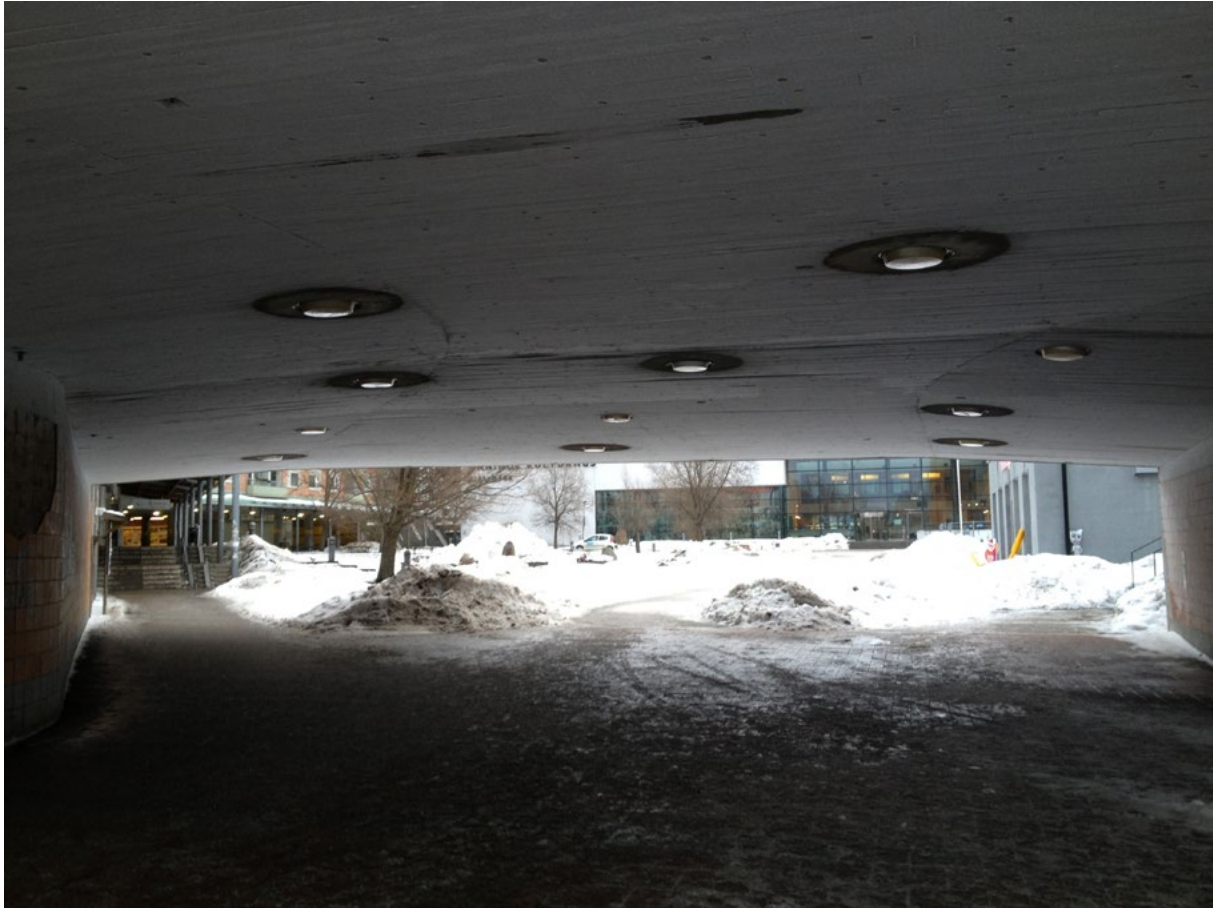
Gångtunnel under Nynäsvägen mot Poseidons torg
