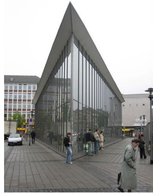
Cykelgarage vid Radstation Münster, Tyskland. Fotograf Krister Isaksson.
