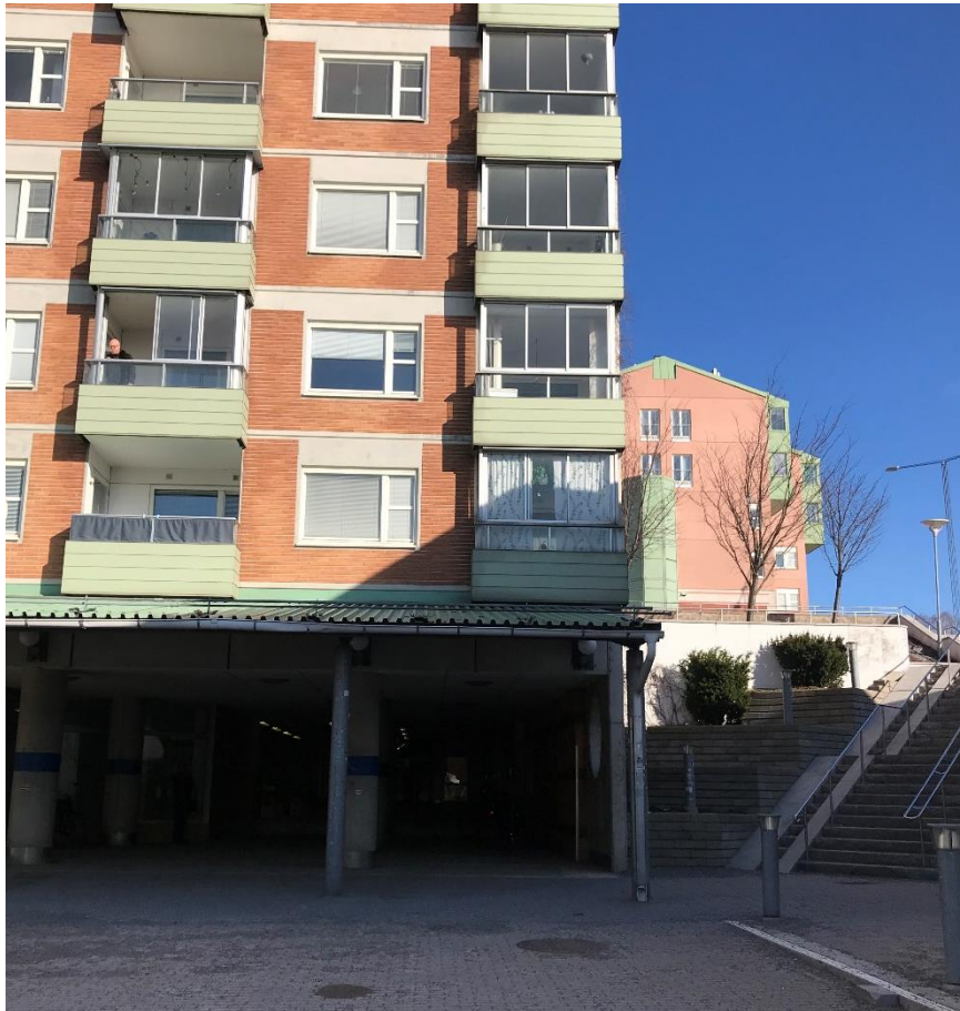
Bild 1.5. Bild som visar södra entrén, flerbostadshus ovan samt trappa till böger.
