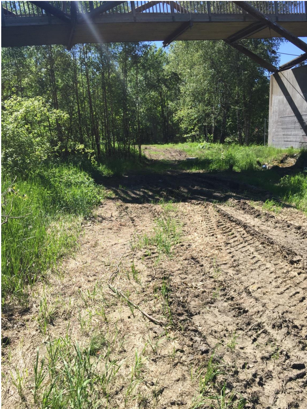
Bild 5. Körspår under Sommarvägen.
