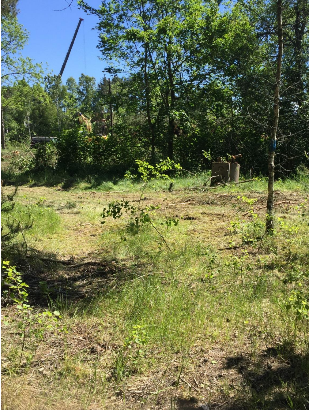
Bild 20. Öster om Haningevägen pågår det röjning och schaktning.
