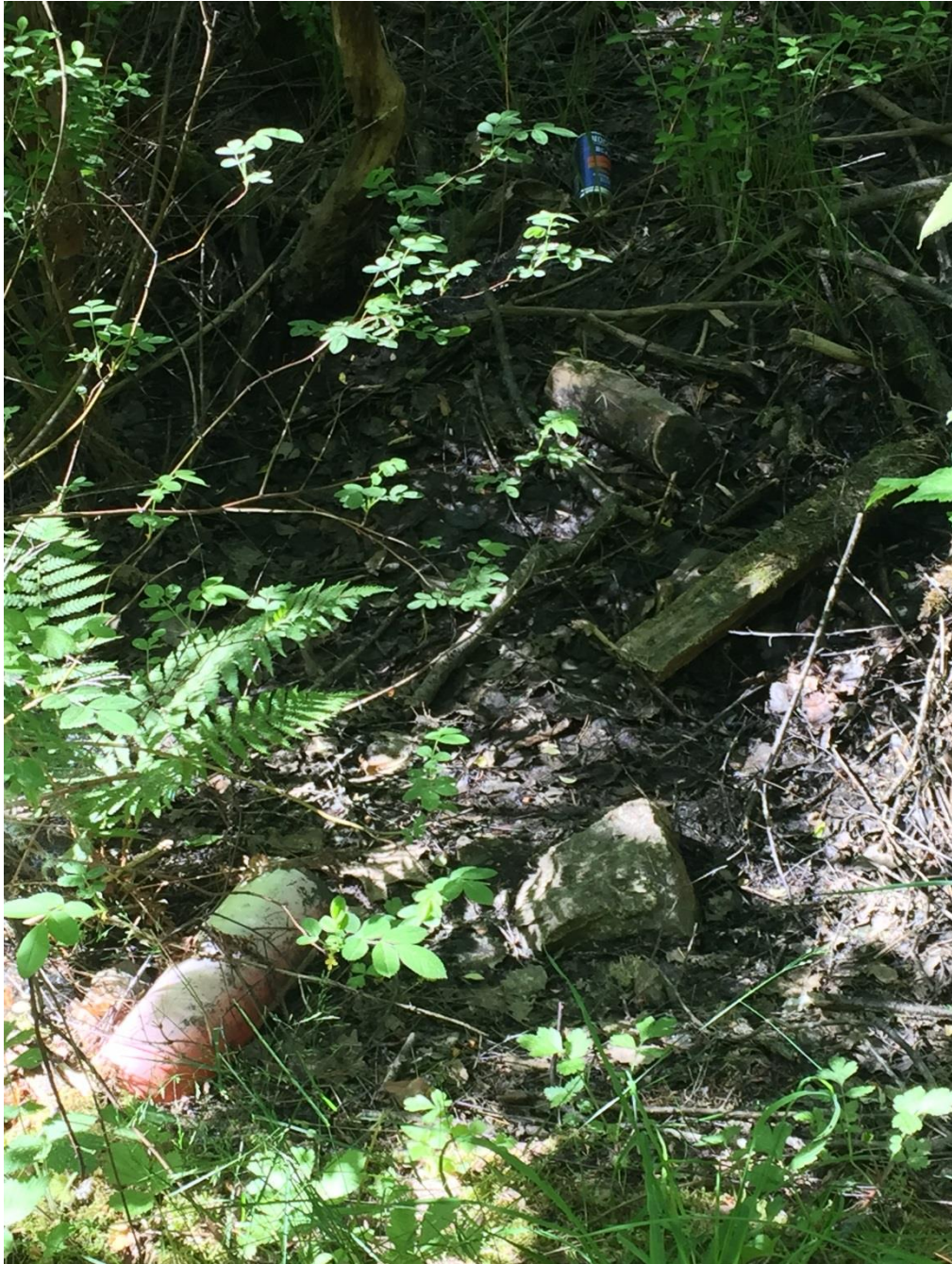
Bild 18. Dike söder om Västravägen. Ett dräneringsrör mynnar ut i detta dike, oklart var dräneringen kommer ifrån.
