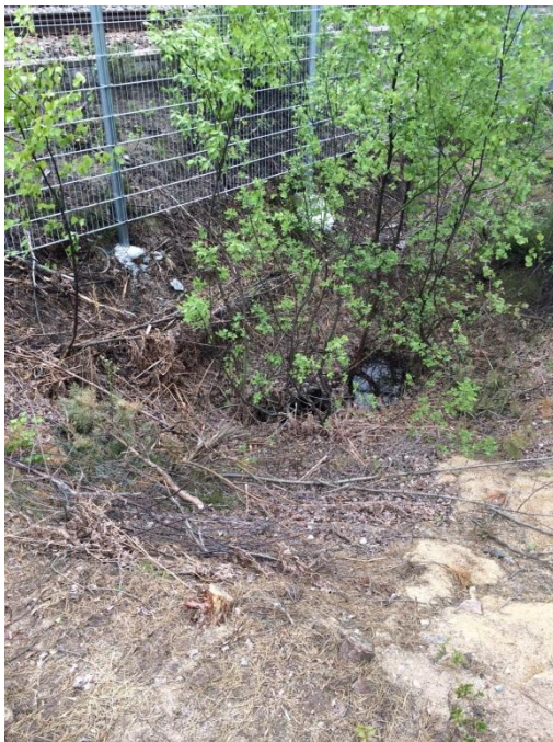
Figur 6. Södra trummans mynning väster om järnvägsrälsen.
