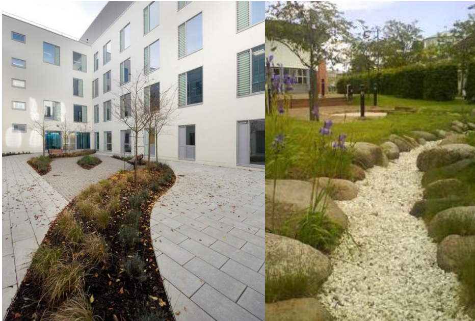
Figur 14. Exempel på stråk för fördröjning av dagvatten i form av växtbädd dragen genom gård med i övrigt hårdgjorda ytor och grusbädd med omgivande gräs – alternativt svackdike/lågstråk (Stockholm stad 2013).
