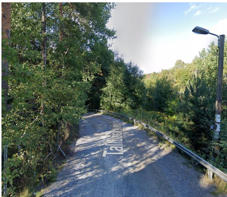
Figur 16: Kurva på Tallbacksvägen, söder om planområdet, strax intill bro över järnvägen. Källa: Google street view 2021.
