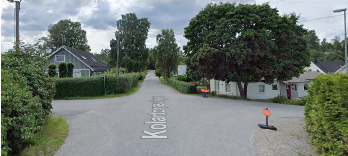
Figur 17: Korsning med högt buskage i korsningen mellan Kolartorpsvägen och Hermanstorpsvägen. Källa Google street view 2022.
