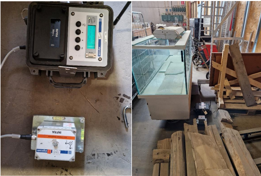
Bild 5-6. Mätpunktsplacering MP3 – Befintlig byggnad
