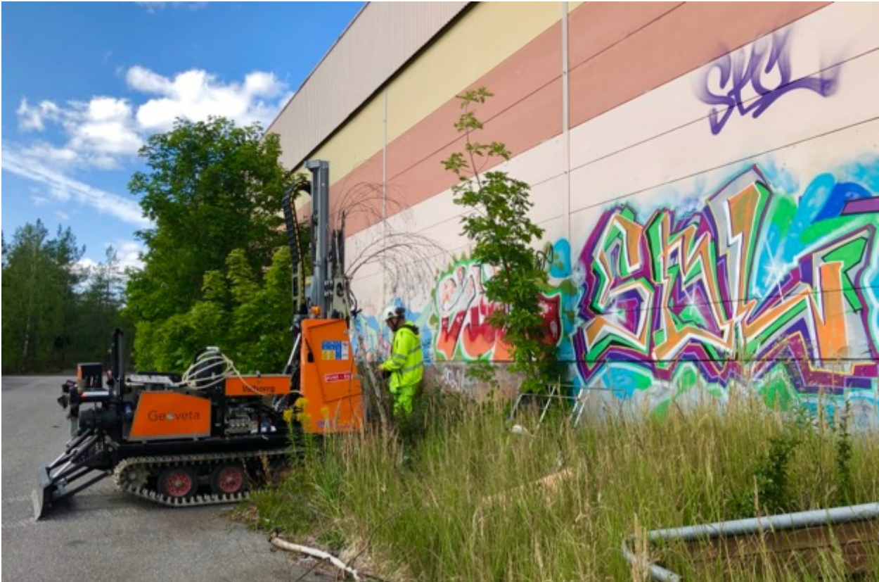
Jordprovtagning med borrhandsvagn intill fastighetens sydöstra hörn.
