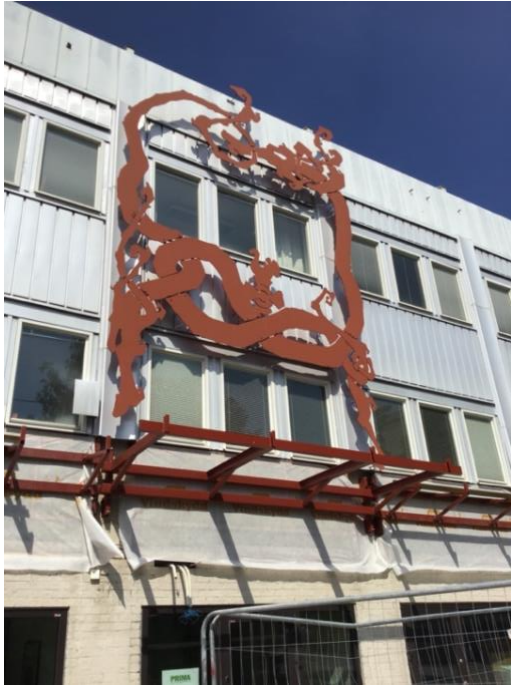
Bild 8 Konst på den östra fasaden.
