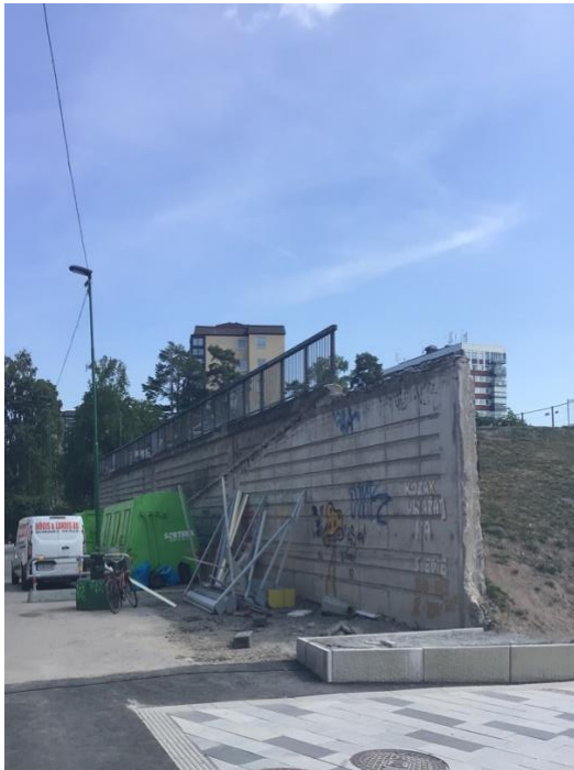
Bild 19 Betongvägg upp mot parkeringsplats
