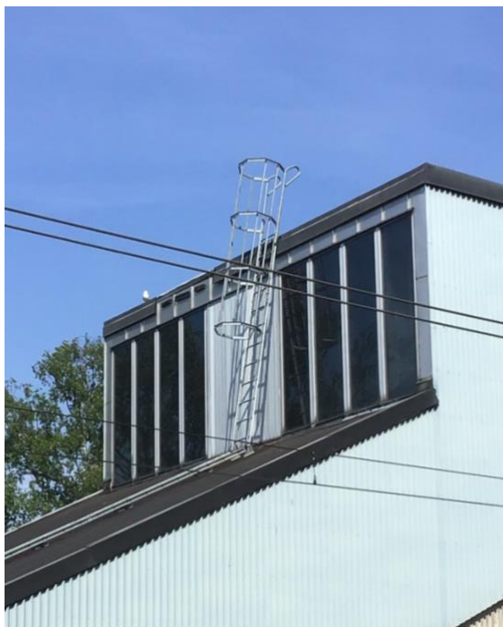
Bild 52 Stege upp mot taket på gångbron
