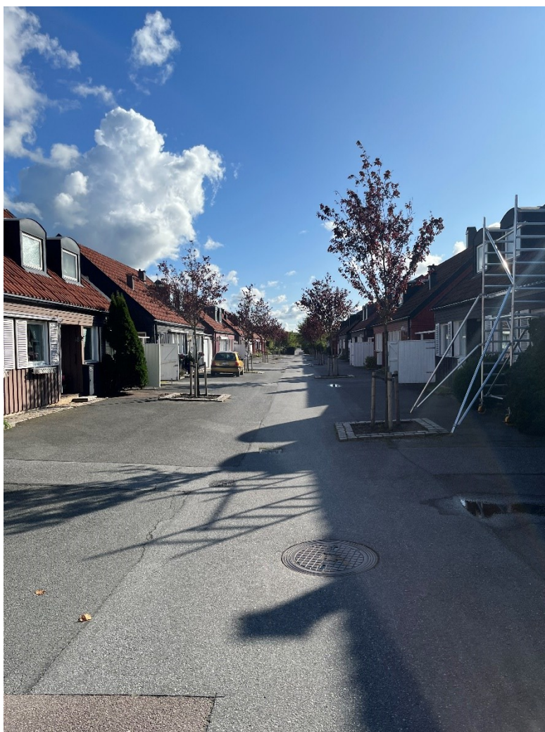
Figur 6-1 Exempel på låglinje längs med en gata, här är gatan vinklad in mot mitten så att vatten rinner från byggnaden. I låglinjen kan rännstensbrunnar eller linjeavvattningsrännor placeras för att förbättra avrinningen till ledningsnätet.
