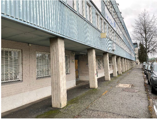
Arkaden utmed Handens Stationsväg
