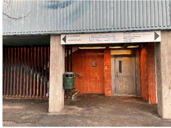
Trappa och hiss mellan Handens Stationsväg och gångbron
