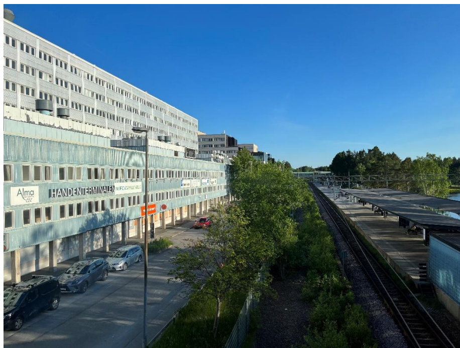
Figur 6. Centrala delen av planområdet. Pendelstationen ses till höger vid sjöns östra sida, Handens stationsväg i mitten och byggnaden Handenterminalen på vänster sida i fotot.
