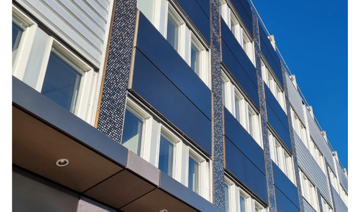
Den nya belysningen i butiksfrenter och på fasad på fasaden mot Haningeterrassen
