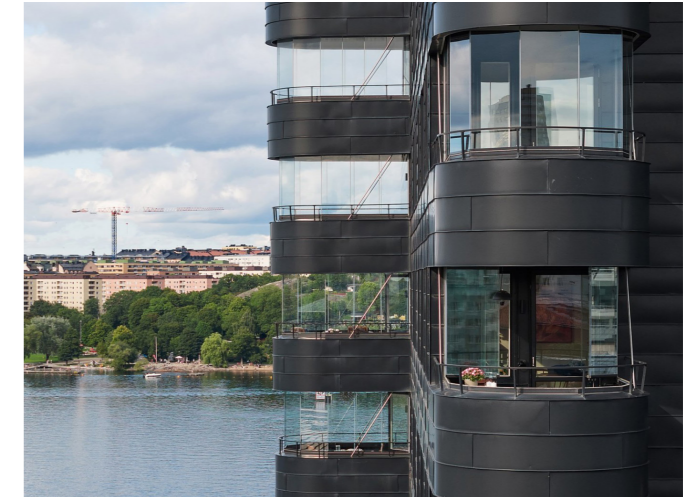
Inglasning av rundade balkonger Kajen 4 - Wingårdh arkitekter
