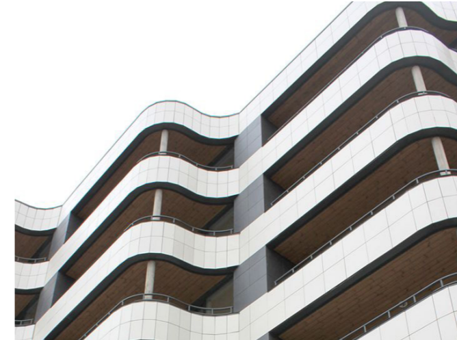
Rundade balkongfronter i fasadkeramik Verkmästaren 1 - Uulas Arkitekter
