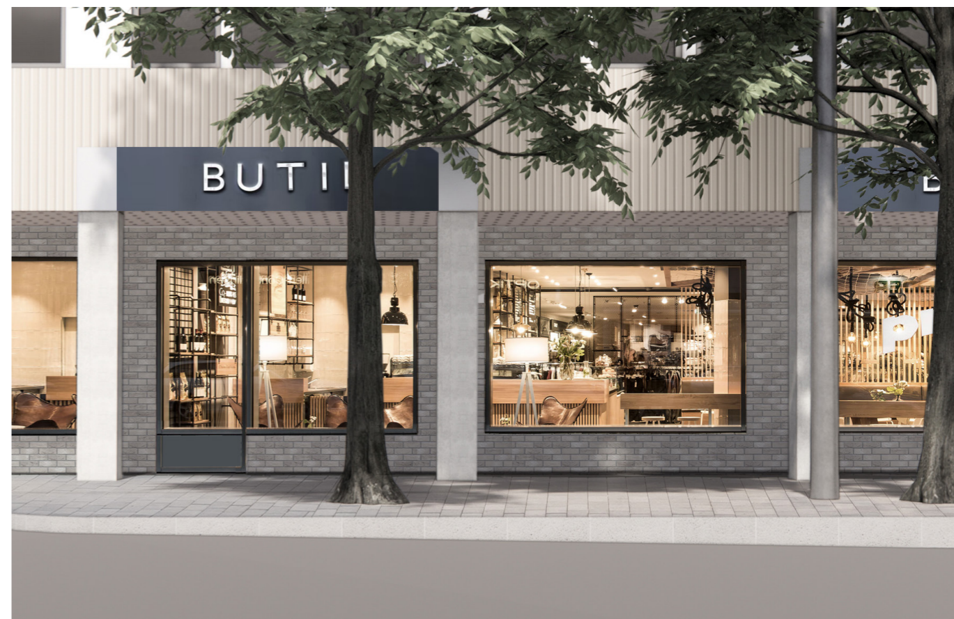
Galler byts mot säkerhetsglas och bröstning sänks.
