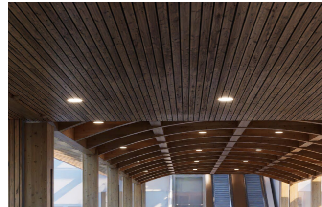
Downlights i stationens gångbro bild: Dissing+Weitling
