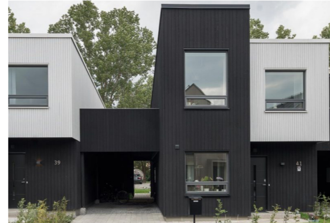
Träpanel i två kulörer Stuterivägen 13 - Wählin Arkitekter
