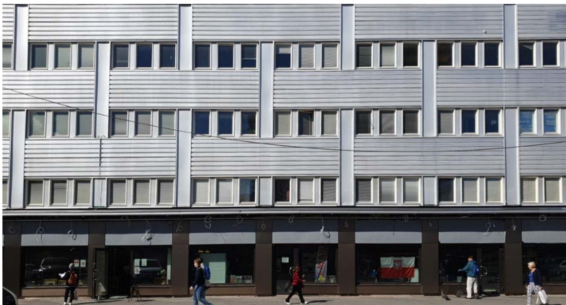
Ursprunglig plåtfasad med grafiskt flätmönster. Bottenvåningens mestisten har klätts in med plåtar. Foton sept 2022.
