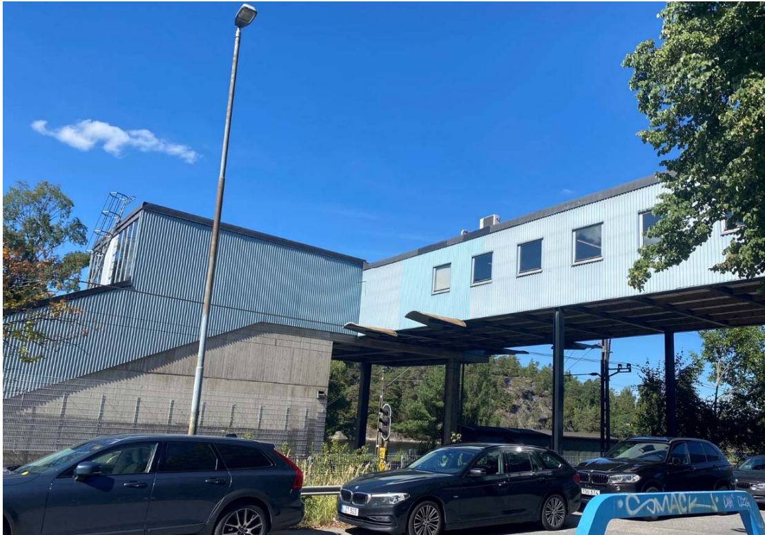
Länken över Handens stationsväg och järnvägsspåren som leder till stationsbyggnaden t v.
