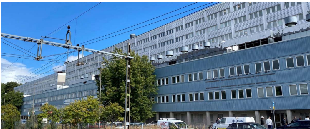
Fasader mot väster med den lägre delen mot Handens stationsväg. Foto sept 2022.
