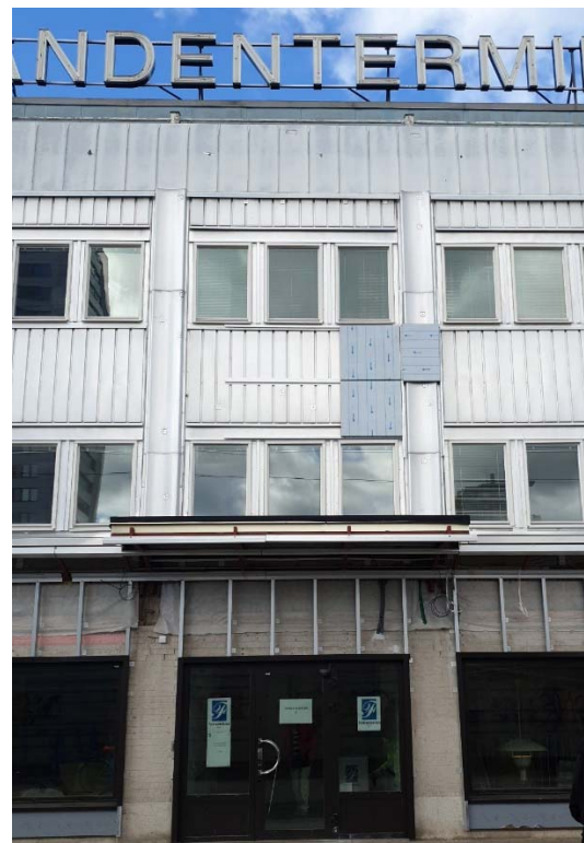
Pågående fasadrenovering där bottenvåningen kläs med plåtkassetter. Foton sept 2022.
