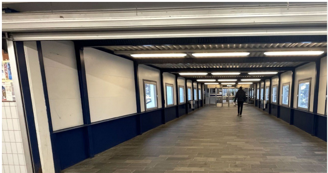
Bild visande befintlig gångbro inifrån, de blå delarna är bärande långbalkar och invändiga stålramar
