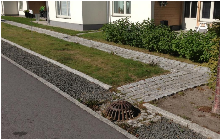
Figur 11. Exempel på infiltrationsstråk i urban miljö.
